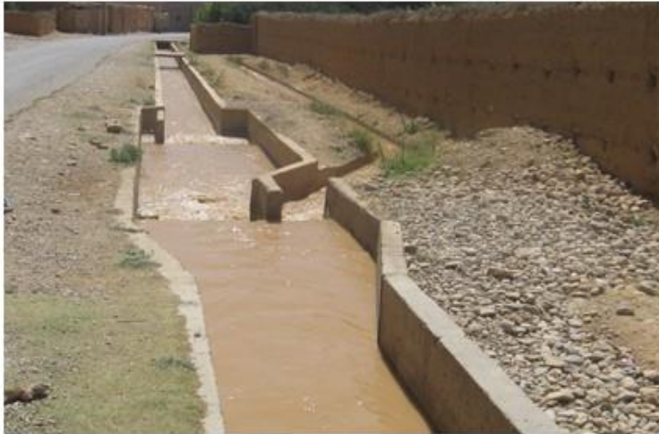
الصورة 4: ساقية السيمة الرئيسية بقطاع ميسور القديم تتوسطها " الفرقة " أي مفرق المياه والتي تتوزع حسب حقوق الملكية
