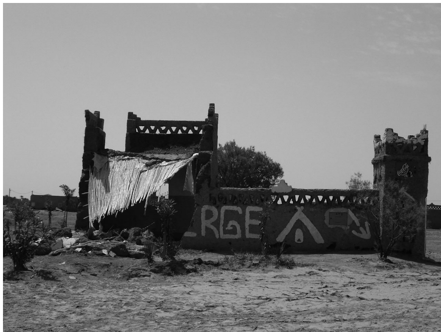
Photo 2 Auberge « Océan des dunes », partiellement détruite (juin 2006).
