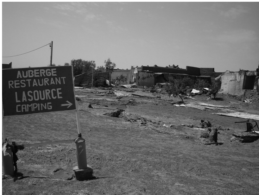
Photo 1 Les décombres de l'ancienne auberge « La Source » (juin 2006) Ruins of the former lodge "La Source" (June 2006).
